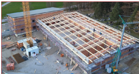
Bauarbeiten am Dachstuhl der Fahrzeughalle
